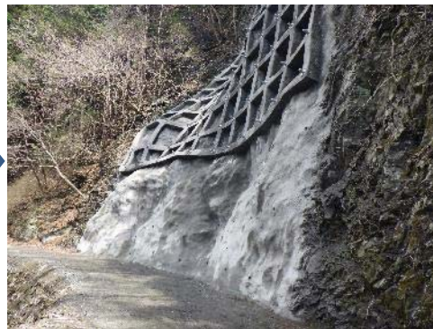
林道峰谷線 (施工後)
