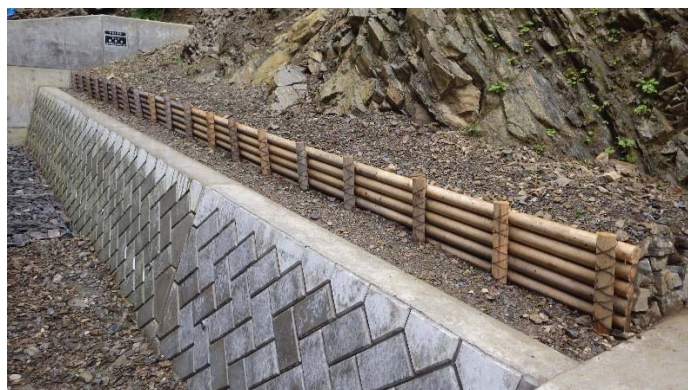
数馬治山施設災害復旧工事 (西多摩郡檜原村数馬)
