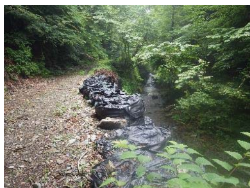
林道矢沢線 (施工前)
