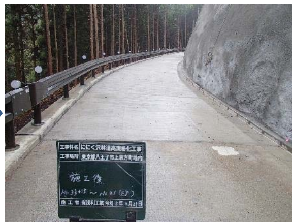
林道ににく沢線（施工後）
