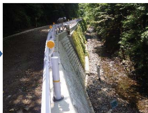
林道矢沢線 (施工後)
