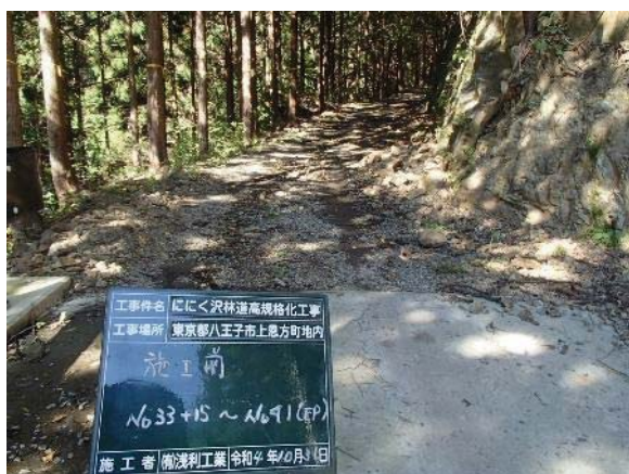
林道ににく沢線（施工前）
