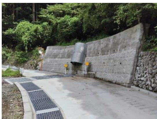
林道鋸山(大沢入)線 (排水構造物工)
