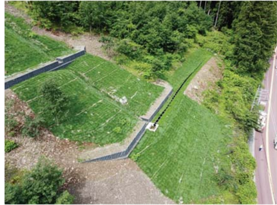
御岳災害関連緊急治山工事 (青梅市御岳一丁目) 工種：大型かご枠土留工・丸太柵工・伏工
