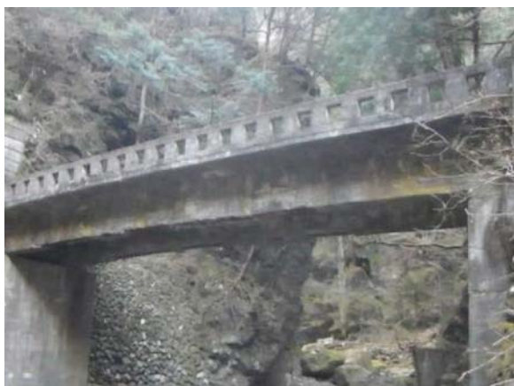
林道海沢線（施工前）
