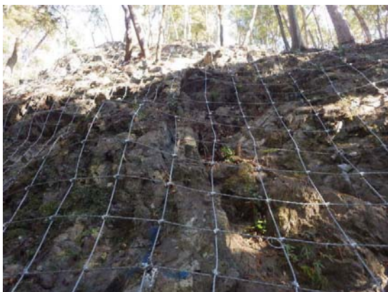
中野（海沢）復旧治山工事 (西多摩郡奥多摩町海沢) 工種：固定（ロープ伏工）
