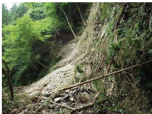
林道峰谷線 (施工前)
