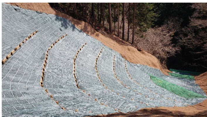
醍醐林地荒廃復旧工事 (八王子市上恩方町)
