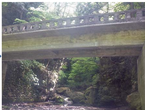
林道海沢線（施工後）
